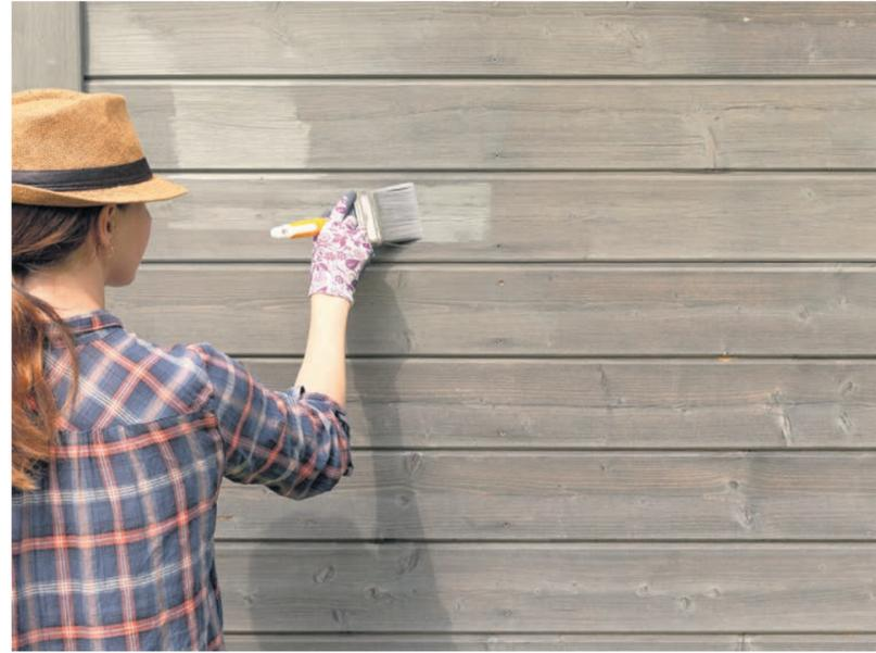
Holz zu imprägnieren, bevor die Behandlung mit Lack, Lasur oder Öl beginnt. Das verlängert die Periode bis zur nächsten Behandlung und sorgt dafür, dass das Holz bei mechanischen Schäden wie Rissen oder Abplatzungen weiter geschützt ist. Eine praktische und einfache Lösung sind auch sogenannte Mehrfachprodukte wie beispielsweise das XYLADecor HSL 2in1, bei denen Grundierung und Lasur enthalten sind. „Hier muss man im Idealfall nur einmal in vier Jahren Streichen“, so Polomski.
